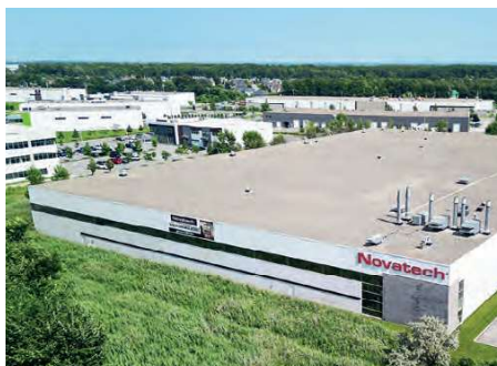
En la planta de Terrebonne, el grupo Novatech produce puertas correderas de PVC para terrazas en cuatro diseños.
