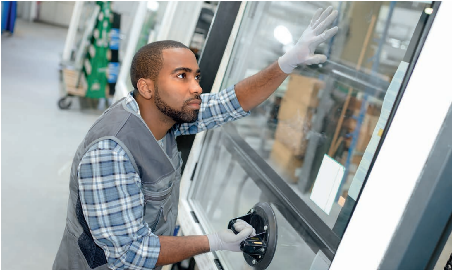
Los vidrios de alta calidad están bien protegidos mediante una inserción de calzos profesional y calzos de acristalar de la mejor calidad.
