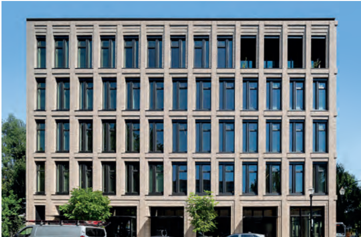
Elementos de vidrio fijos a la altura de la estancia y elementos Casement & Awning con herrajes Roto X-Drive proporcionan mucha luz natural al edificio “PAE Living Building” en Portland, Oregon, EE. UU.
